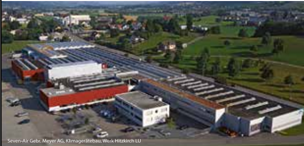
Seven-Air Gebr. Meyer AG, Klimagerätebau, Werk Hitzkirch LU
